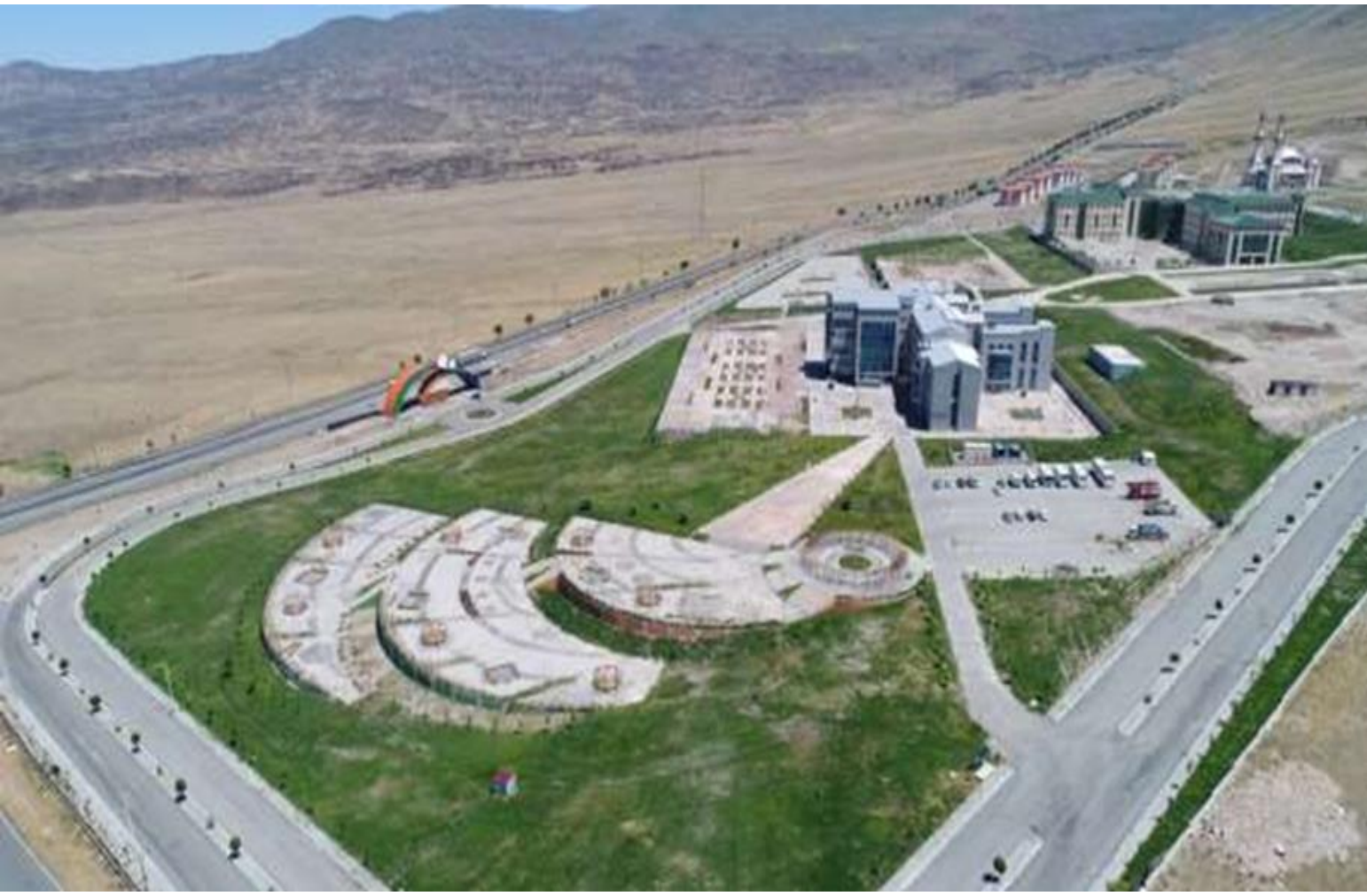
1000 DÖNÜMLÜK ALANDA PEYZAJ YAPIM İŞİ
