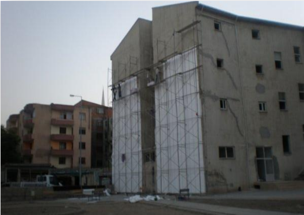
Bakım Onarım Öncesi Rektörlük Binası
