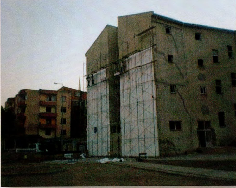
Bakım Onarım Öncesi Rektörlük Binası
